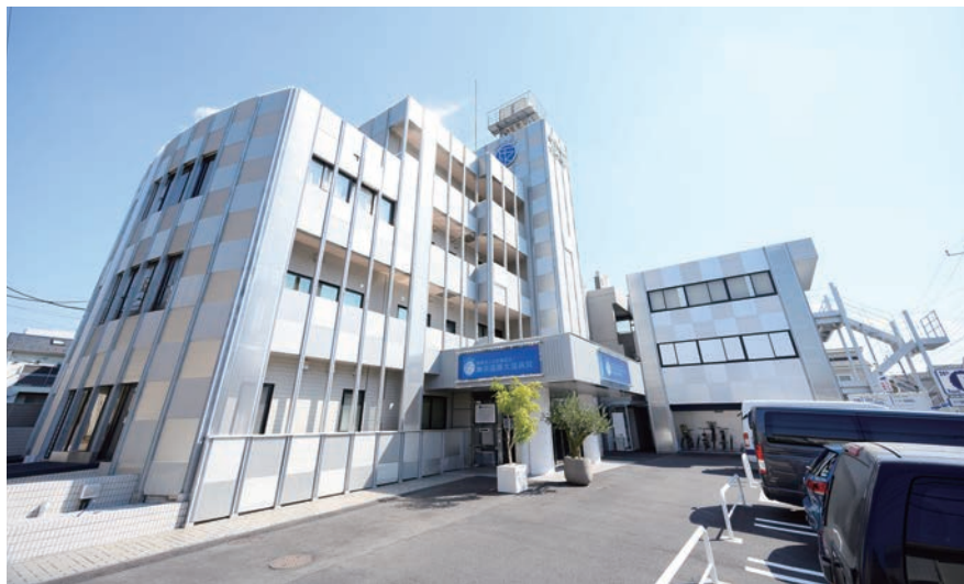
東京国際大塚病院では月曜日から金曜日まで手術を行っている
